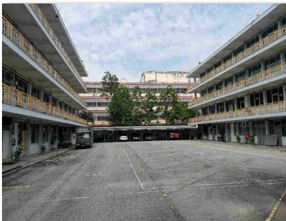
Bangunan Bekas Pejabat PLANMalaysia yang telah Berpindah ke Putrajaya
